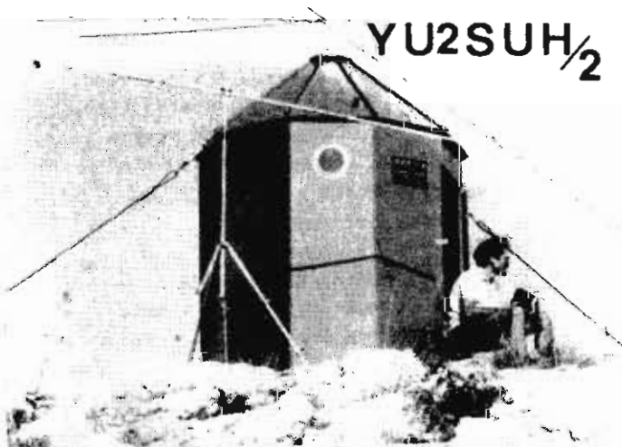
SLAVEN - YU2SUH/2 NA MOSORU, VRH "VI- CKOV STUP" (1352m). UREDJAJI ZA PORTABL RAD SU FT-290R I ANTENA "TONNA" OD 9 ELEMENTA.
